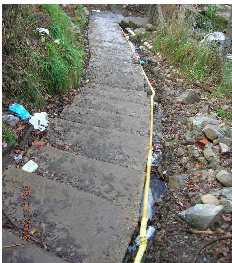
Figura 4-5 -Tendido de gas expuesto sobre lateral de escalera
