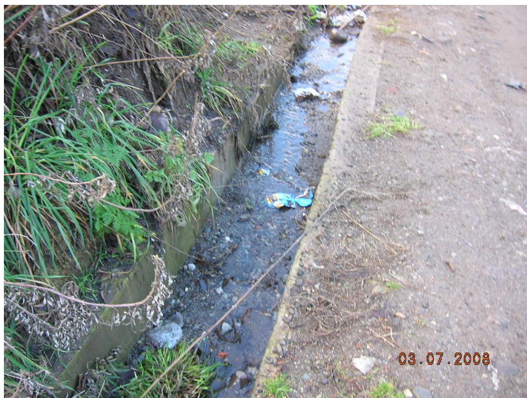
Figura 4-17 – Sedimentos y basura en canal de hormigón
