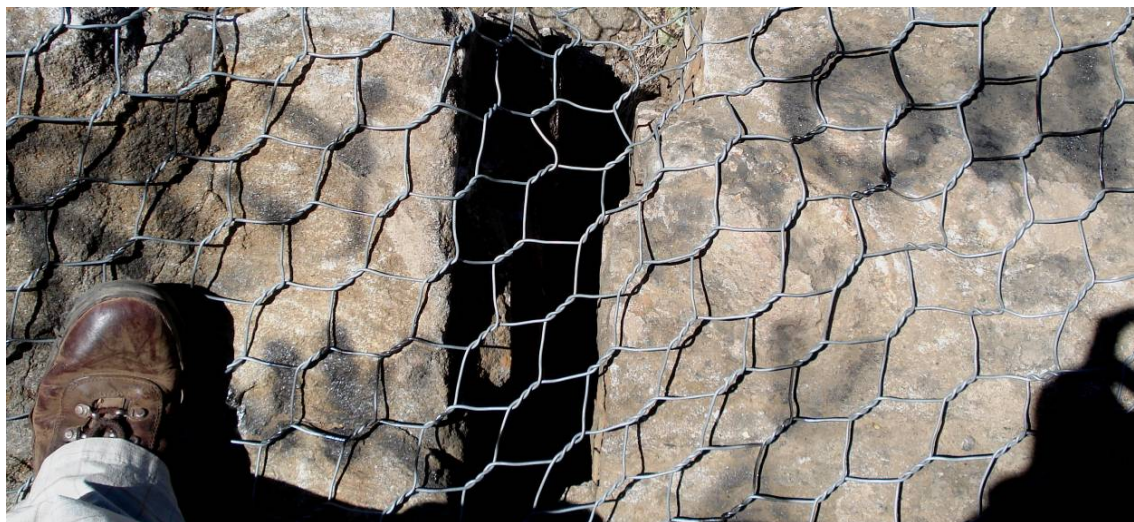
Figura 7-11 – Diaclasas abiertas con separación de 15 cm, sector marginal de la pendiente situada en la sección superior del Barrio Vallejos.
