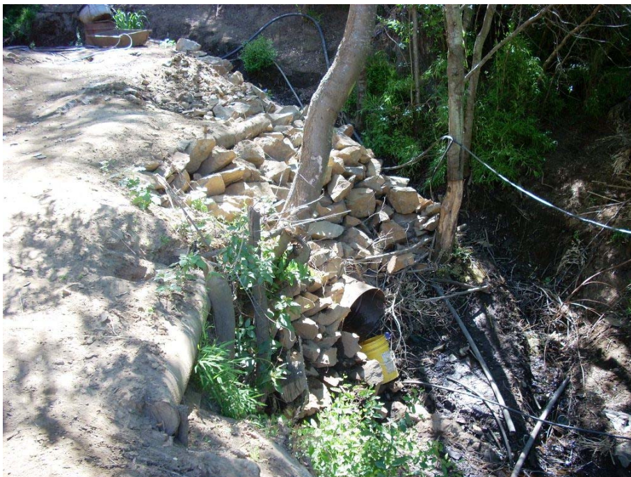
Figura 4-9 – Relleno, muro precario y conducto sobre cauce de arroyo
