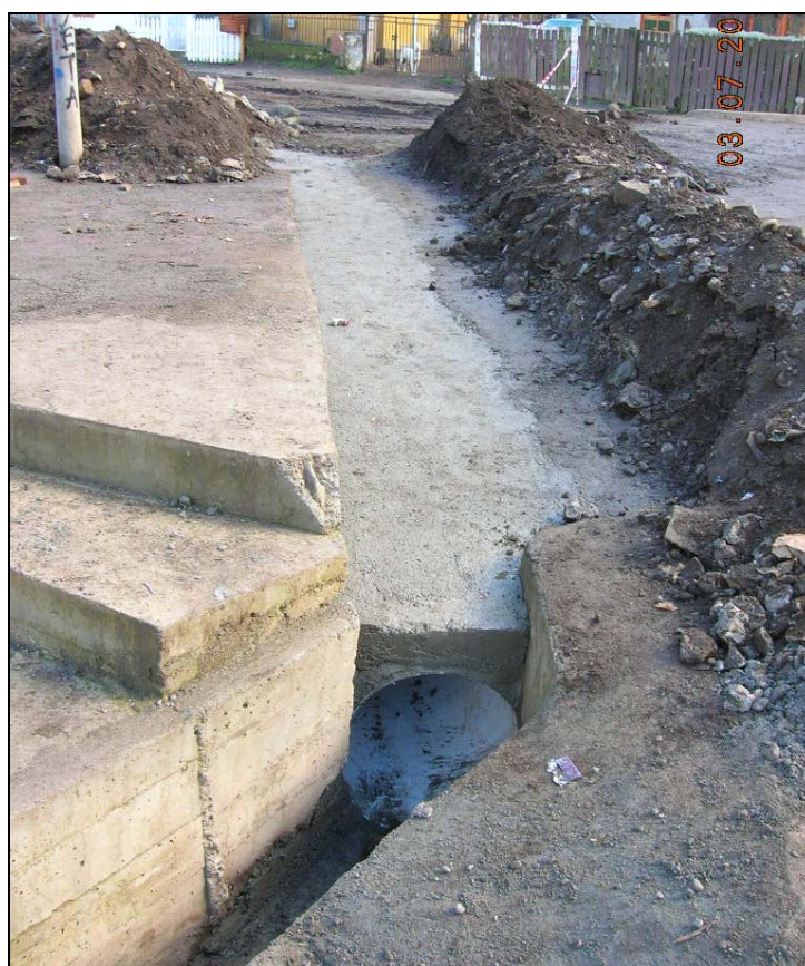
Figura 10-33 – Conducto de PVC y hormigón (obra PROMEBA)
