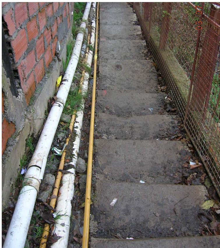
Figura 4-6 -Tendido de gas y cloaca expuesto por falta de espacio
