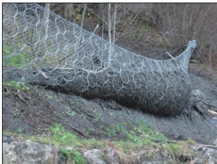
Figura 10-2 –Barrera flexible en deslizamiento de rocas y suelo
