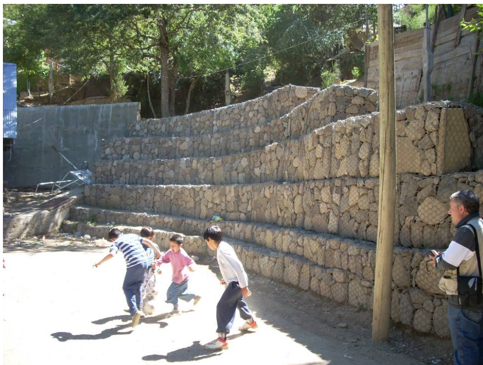
Figura 10-45 – Muro de contención en barrio Vallejos (obra PROMEBA)
