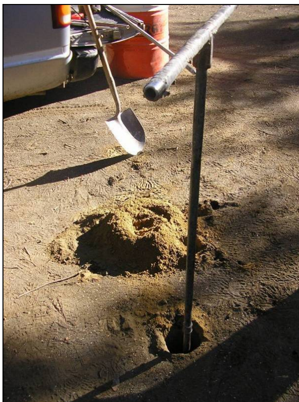
Figura 5-3 – Excavación manual con pala tipo vizcachera
