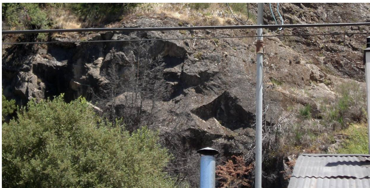
Figura 7-7 – Formación de diedros sobre el talud por desprendimiento de bloques prismáticos Barrio Calderón.
