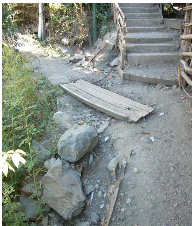
Figura 4-8 - Socavación al pie de escalera peatonal
