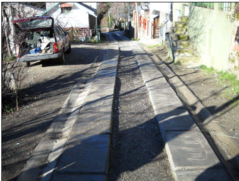
Figura 10-42 – Pavimento y drenaje lateral (obra PROMEBBA)
