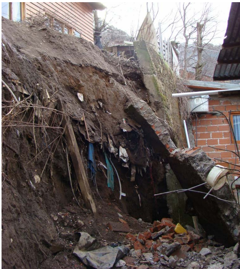
Figura 4-11 – Derrumbe de vivienda por inestabilidad geotécnica
