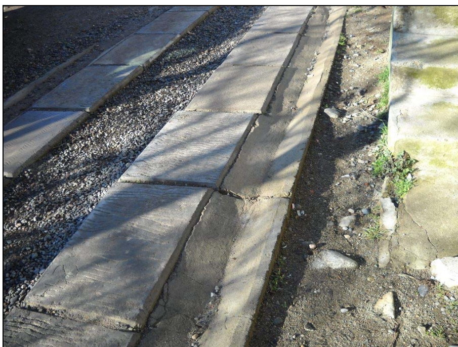
Figura 10-43 – Erosión y deterioro de cuneta rígida (obra PROMEBBA)
