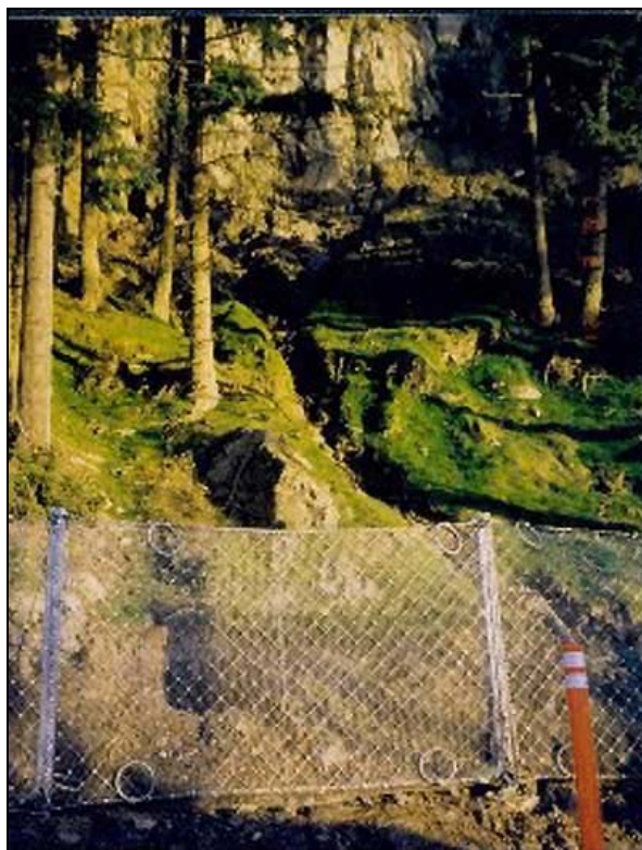
Figura 10-1 – Sistema de barrera flexible para control de caídas de roca
