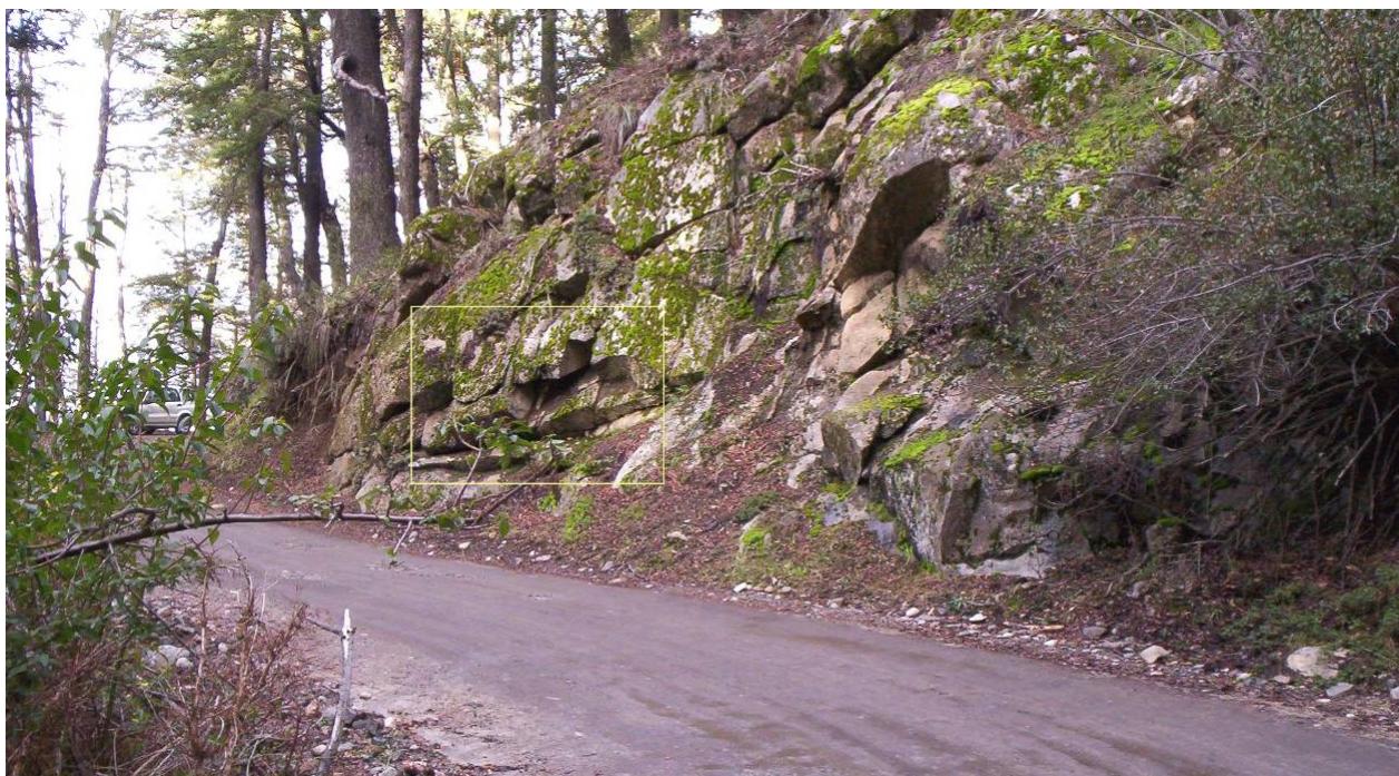
Figura 7-32 -. Corte de pendiente situada a 940 m de altura, y a 300 m por encima del Barrio Calderón. Se observan gran número de planos de diaclasas que favorecen movimiento del tipo deslizamiento traslacional y avalancha de rocas. El recuadro indica la localización de la Figura 7-33
