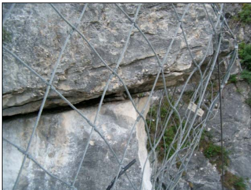
Figura 10-17 – Ejemplo de aplicación de panel de cables de refuerzo
