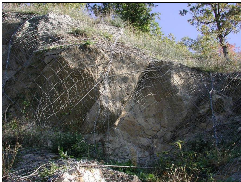
Figura 10-18 – Ejemplo de aplicación de panel de cables de refuerzo
