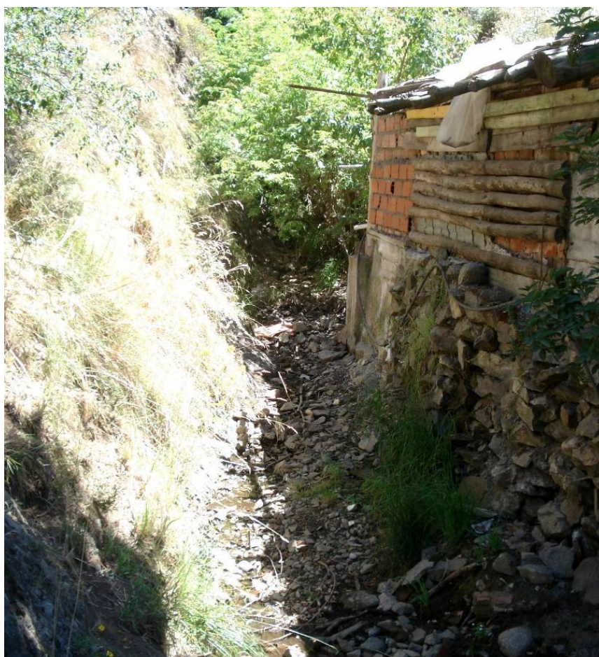
Figura 7-23 - Vivienda parcialmente fundada sobre acumulaciones fluviales actuales. Barrio Godoy
