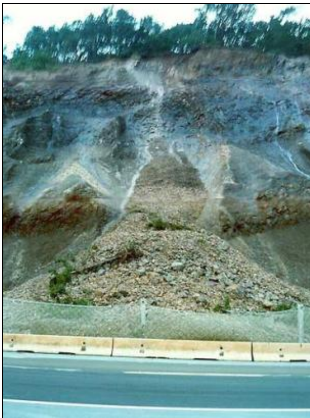
Figura 10-3 –Barrera flexible en deslizamiento de rocas y suelo
