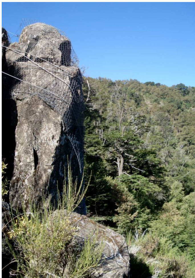
Figura 7-4 – Plano de fracturación vertical a parcialmente colgante sobre la cara libre del afloramiento. Este juego de diaclasas da lugar a movimientos de remoción en masa del tipo volcamiento y caída de rocas
