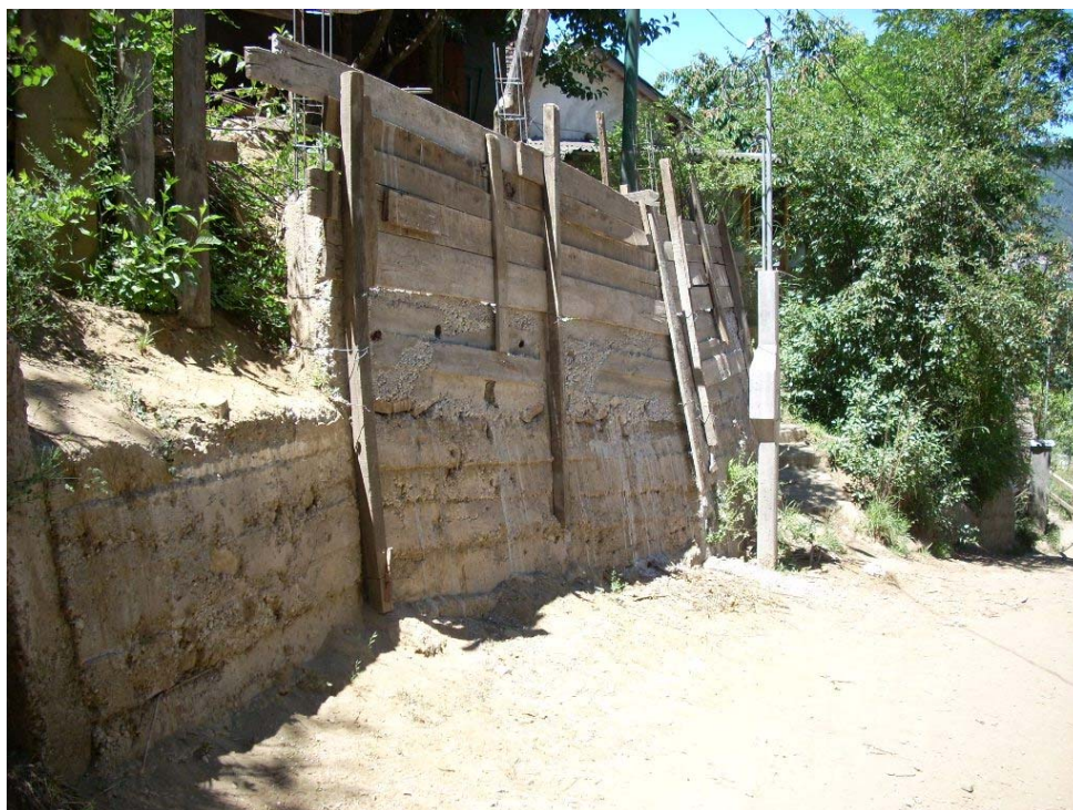
Figura 10-47 – Muro de contención de construcción precaria
