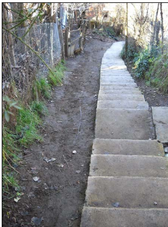
Figura 10-44 – Erosión y deterioro del drenaje lateral (obra PROMEBA)
