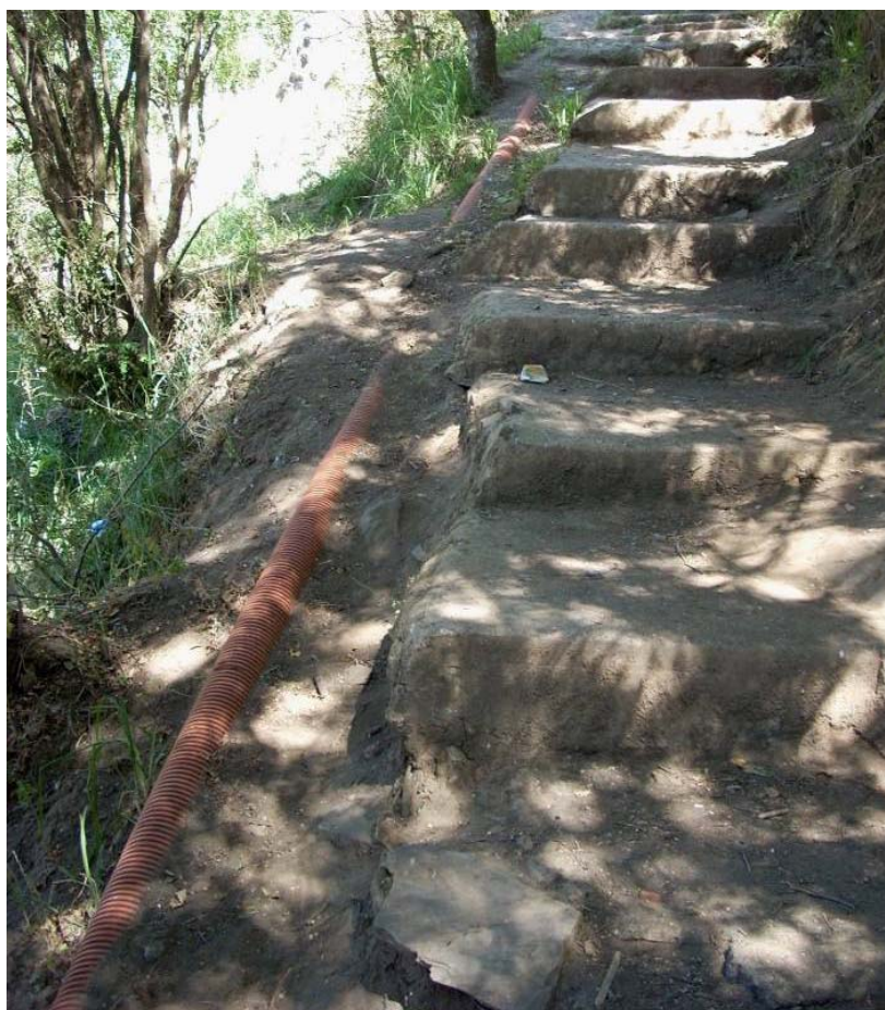
Figura 4-3 - Tendido de ducto cloacal expuesto
