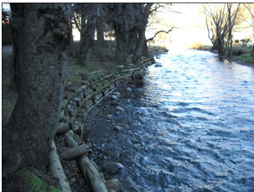
Figura 10-35 – Defensa de margen rustica en A° Pocahullo (muro de palos y piedra)
